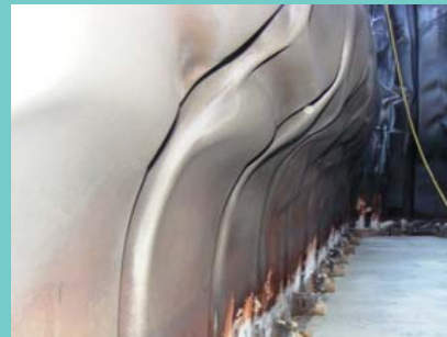
Verformungen in der MA-Wall
